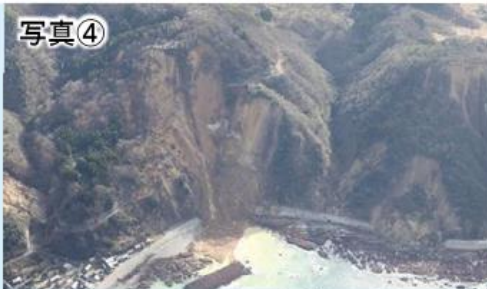
国道249号法面崩落
