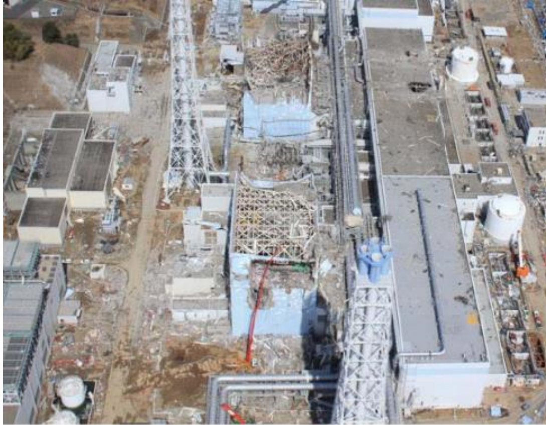
写真2. 1. 3-2 事故後の福島第一原発1~4号機 (南側から) 46 (国会事故調報告書158頁)
